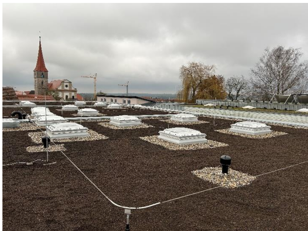
Gründach auf dem Erweiterungsbau des Kindergartens
