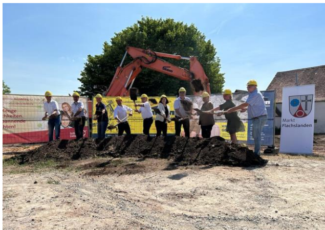
Spatenstich für das Haus der Pflege am 02.06.2023
