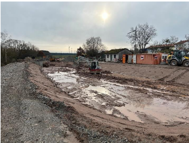
Umbau der alten Kläranlage zum Regenrückhaltebecken und Regenüberlaufbecken
