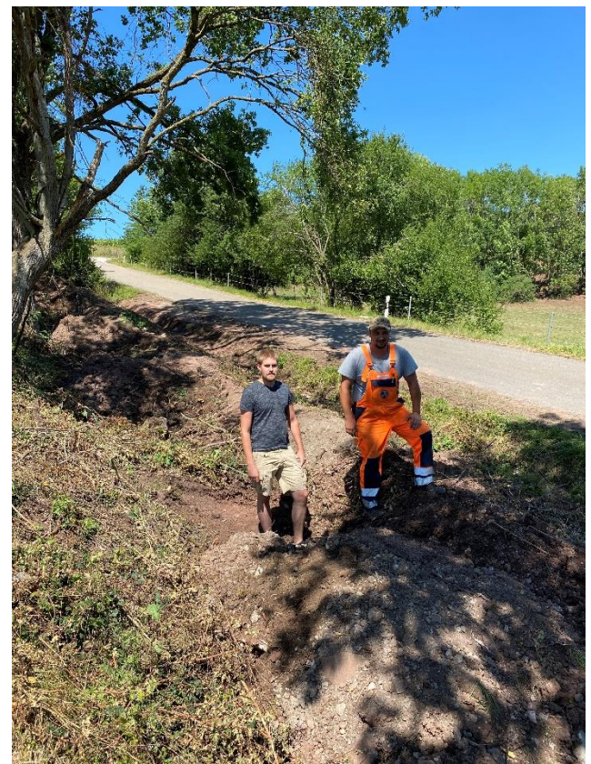
Peter Böhm von Baader Konzept und Bauhofmitarbeiter Harry Dämpfling vor Ort in Schmalnbühl
