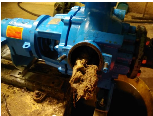
Unappetitliche Verstopfung in der Pumpe
