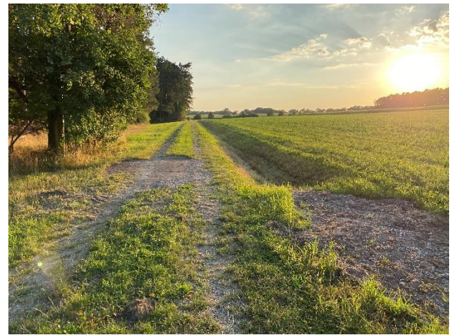
Einfach Mulde zum Ableiten von Hochwasser aus dem Graben in die benachbarte Waldfläche
