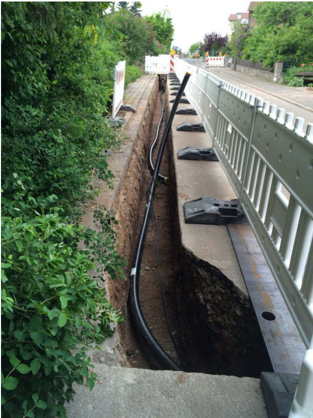
Verlegung der Wärmeleitung in der Wiesenstraße
