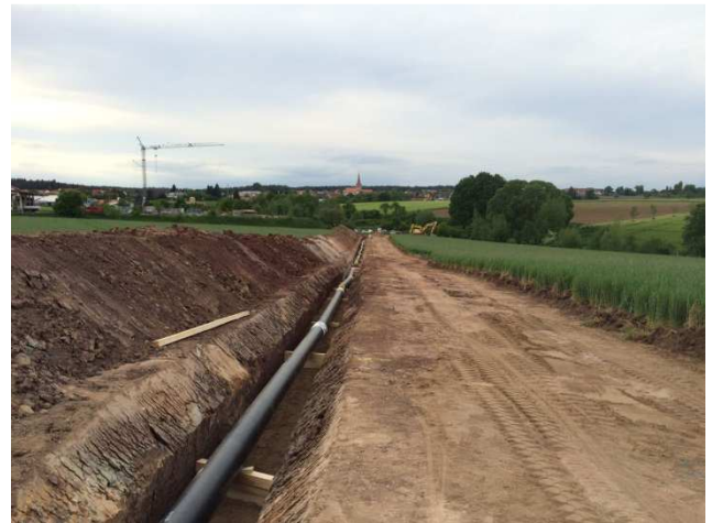
Verlegung der Wärmeleitung zwischen Biogasanlage und Kläranlage
