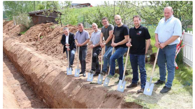
Mit einem symbolischen Spatenstich haben Bürgermeister Hans Henninger, Bernd Galm vom Ingenieurbüro, Horst Grita, Joachim Heidingsfelder, Sebastian Rabenstein, Christian Lang und Gerhard Popp (von links) den Beginn des Baus des Wärmenetzes eingeleitet. Foto: Biernoth
