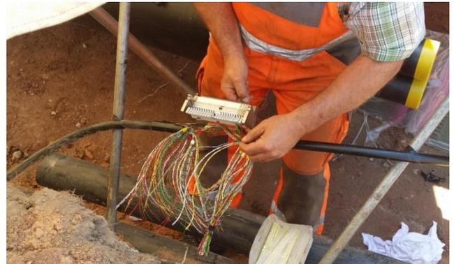
Verlegung der Datenkabel zur Steuerung und Fernauslesung
