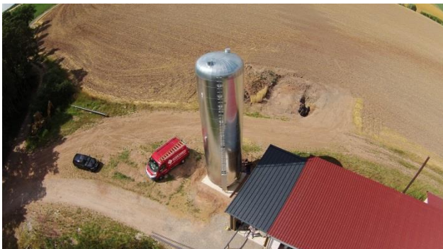
Pufferspeicher an der Biogasanlage
