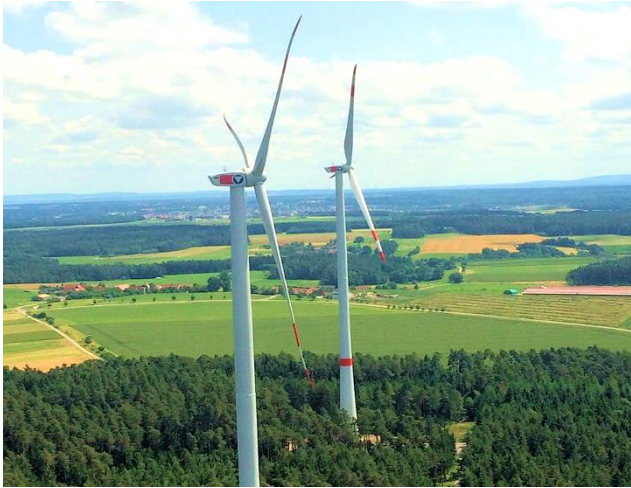
Zwei der vier Anlagen des NorA-Bürgerwindparks Birkenfels
