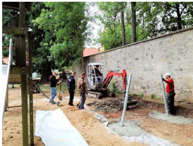
Der Untergrund für die Nestschaukel wird hergestellt
