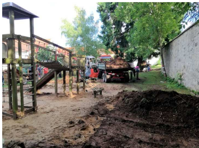
Erdarbeiten mit schwerem Gerät
