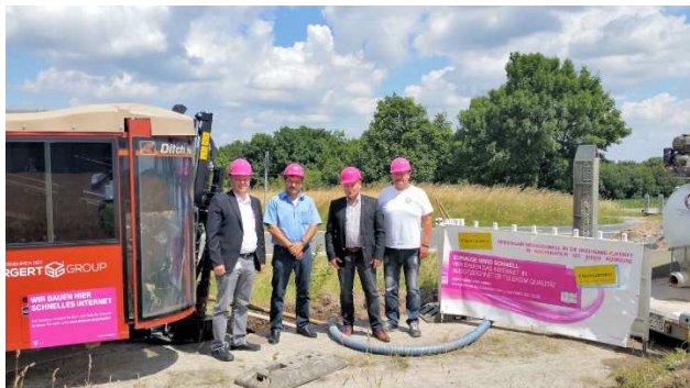
Herr Winter und Herr Braun von der Telekom (links) sowie Herr Iffländer von der ausführenden Fa. Bergert (rechts) mit Bürgermeister Henninger bei einer Spülbohr-Baustelle am Roten Kreuz
