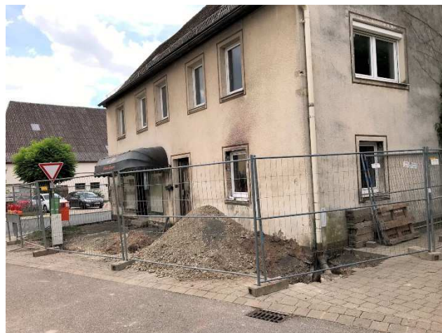
Bauvorbereitende Arbeiten an der neuen Arztpraxis
