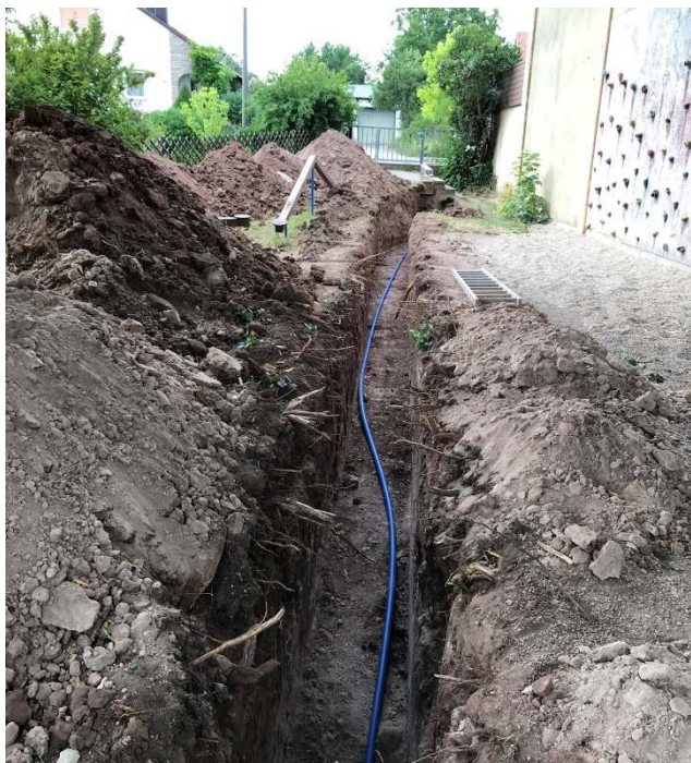
Verlegung der neuen Wasserleitung
