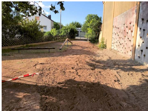
Der Graben an der Westseite der Mehrzweckhalle ist schon wieder geschlossen
