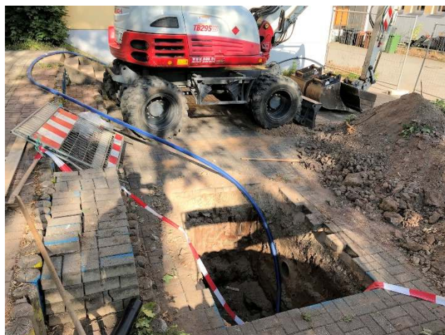
Öffnung für Spülbohrung im Pausenhof
