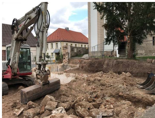
Archäologische Untersuchungen wurden vor der Erstellung des Fundaments vorgeschrieben
