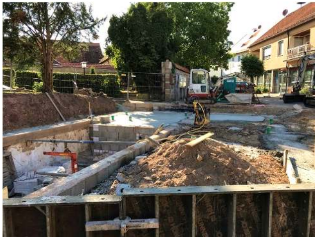
Die Arbeiten für das Fundament kommen voran
