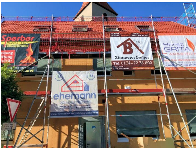
Blick von außen auf die Baustelle
