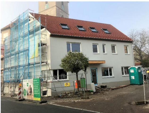
Blick von außen auf die Baustelle
