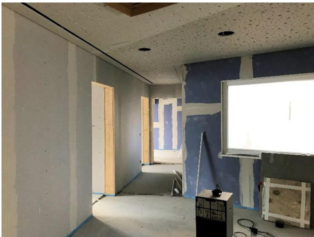
Der Zugangsbereich zu den Sprechzimmern im aktuellen Bauzustand
