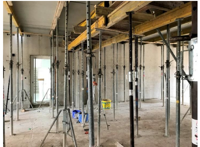
Die abgestützte Decke in der neuen Aula. Im Hintergrund der Zugang zum Rathaus
