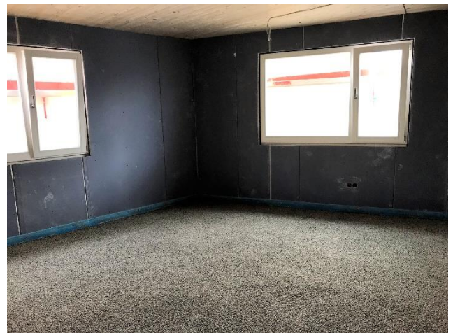
Fußbodendämmung im Wartezimmer
