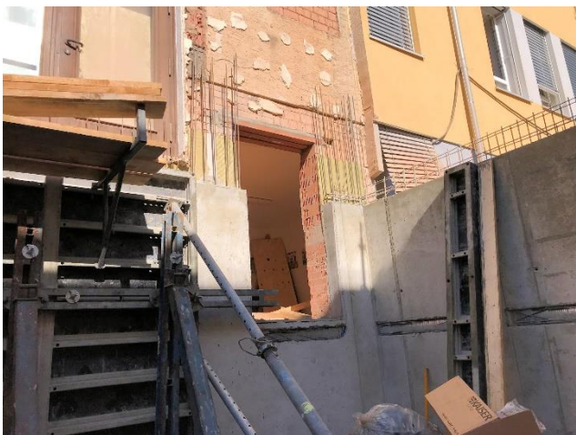
Der neue Zugang vom Aufzug in die Schule
