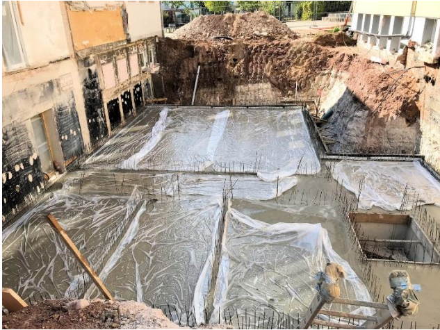
Betonieren der Bodenplatte
