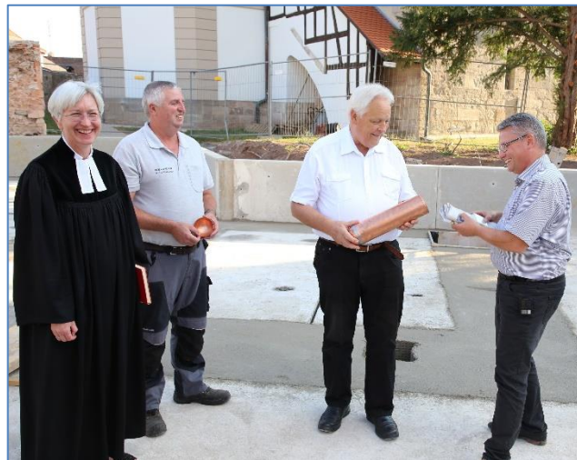
Pfarrerin Elisabeth Franz-Chlopik, Spengler Rudolf Neumeier, Architekt Rudi Hirsch und Bürgermeister Hans Henninger beim Befüllen der Grundsteinkapsel (von links). Foto: Biernoth
