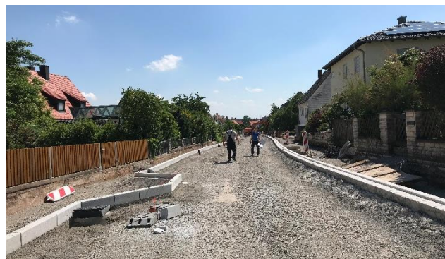
Der Verlauf des Gehsteigs und der Grünflächen sind schon gut erkennbar.
