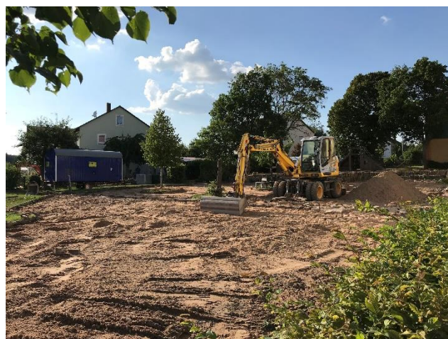
Das alte Pflaster ist bereits ausgebaut
