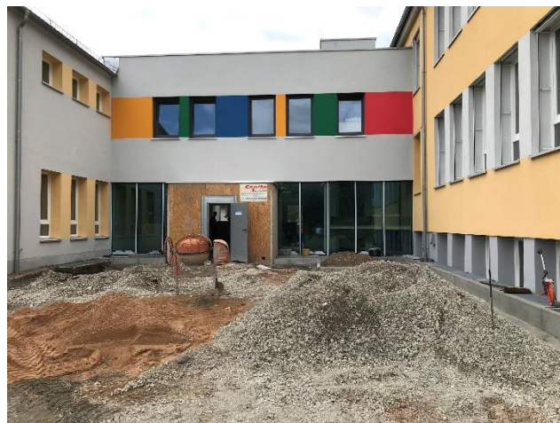
Arbeiten am neuen Eingangsbereich der Schule
