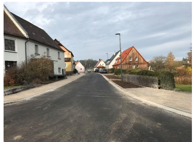
Die Einfahrt in die Rosenbacher Straße von der Ansbacher Straße
