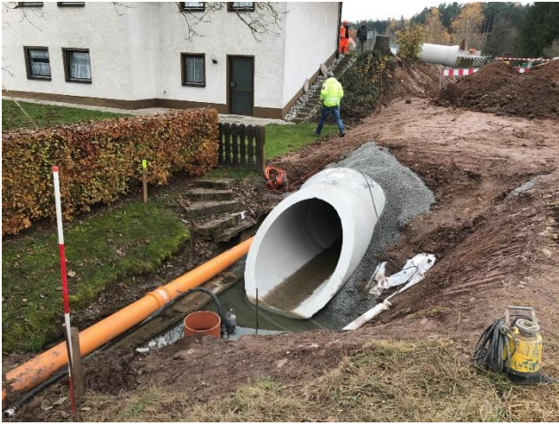
Der Auslauf der neuen Verrohrung
