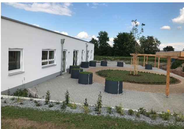
Der Außenbereich der Tagespflegeeinrichtung im Kellerfeld
