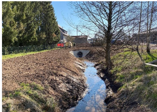
Der westliche Einlauf der Beckengrabenverrohrung
