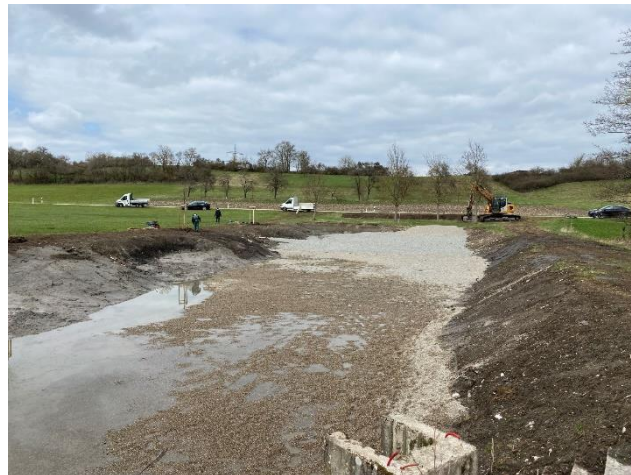
Blick vom Damm
