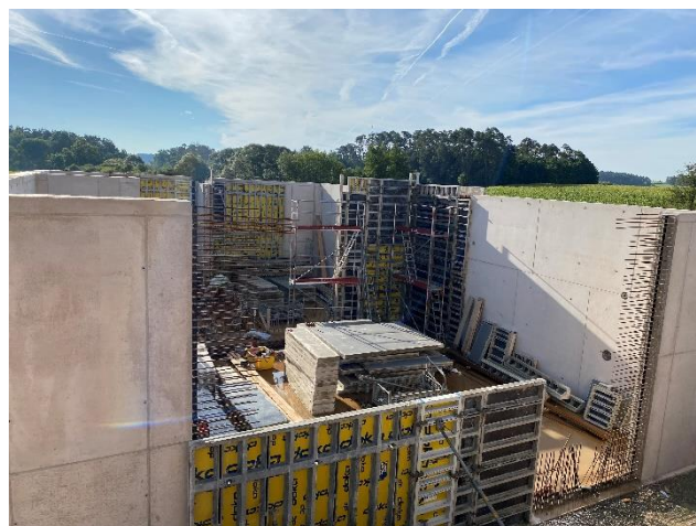
Rohbauarbeiten am neuen Klärbecken der Kläranlage Flachslanden im September 2022
