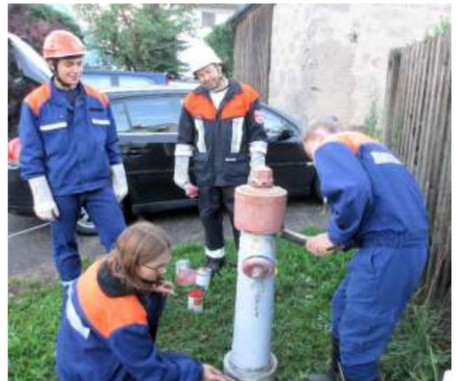
Im ersten Schritt wurden die Hydranten gereinigt. Mit Stahlbürsten und Muskelkraft ging es Schmutz, Rost und der alten Farbe an den Kragen.
